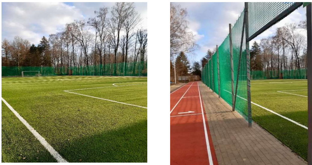
Boisko szkolne po przebudowie
